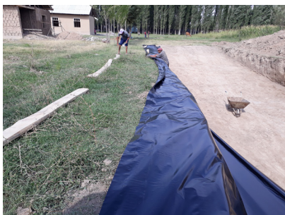
Сурет 2: Даярдалган жерди пленка мн жабуу
