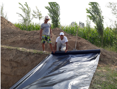
Сурет 2: Даярдалган жерди пленка мн жабуу
