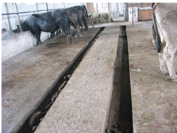
Сүрөт 3. Малканадагы мал жатчу жер, акырлары, кык турчу жер жана мал сейилдөөчү аянтча
