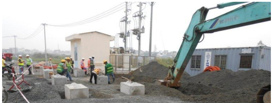
Lắp đặt đường dây dẫn điện phục vụ hệ thống xử lý (Ảnh: CDM Smith)
