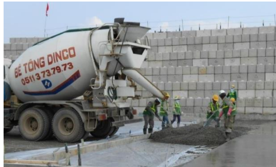
Xây nền của hệ thống xử lý chất lỏng và hơi (Ảnh: CDM Smith)
