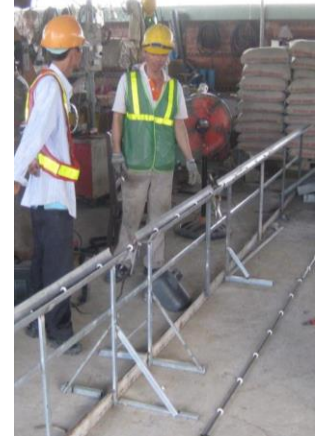
Sửa chữa bộ phận truyền nhiệt (Ảnh: TerraTherm)
