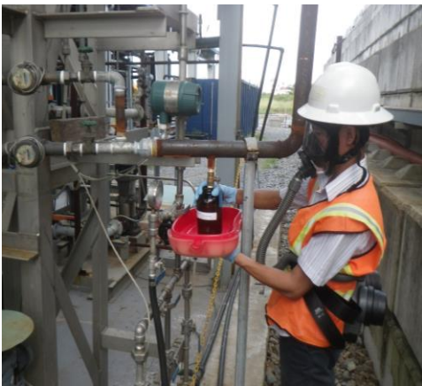
Thu thập mẫu chất lỏng từ nhà máy LVTP trong quá trình vận hành xử lý nhiệt (Ảnh: CDM Smith)
