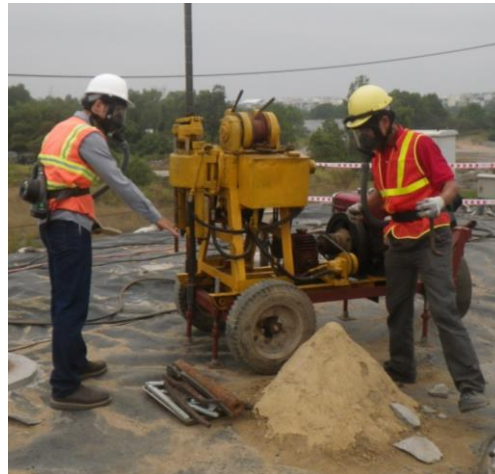
Lấy mẫu giữa kì trên đỉnh kết cấu xử lý (Ảnh: CDM Smith)
