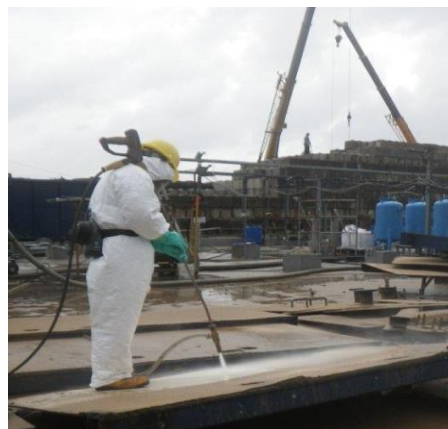
Làm sạch thiết bị tại hệ thống xử lý chất lỏng và hơi. (Ảnh: CDM Smith)
