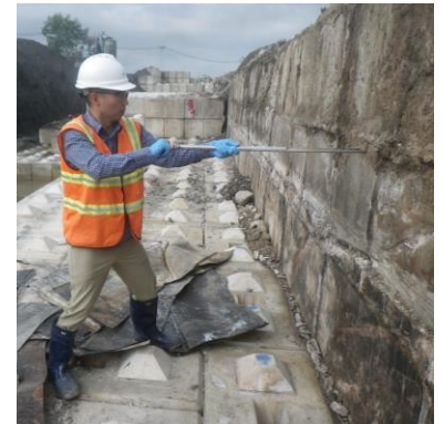
Lấy mẫu từ thành cửa móng xử lý. (Ảnh: CDM Smith)
