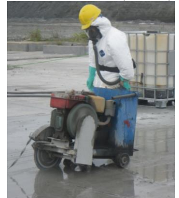
Cất mặt sàn bê tông để xử lý. (Ảnh: CDM Smith)
