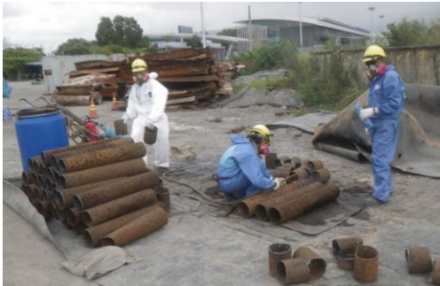
Làm sạch các ống thu nước rỉ thải dỡ từ đáy mố xử lý. (Ảnh: CDM Smith)
