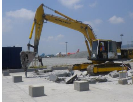
Tháo dỡ các kết cấu/hạng mục của hệ thống xử lý. Ảnh bên trái: bê tông trạm xử lý hơi và chất lỏng; ảnh bên phải: bể chứa nước của tháp làm mát. (Ảnh: CDM Smith)
