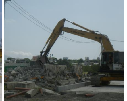
Tháo dỡ các kết cấu/hạng mục của hệ thống xử lý. Ảnh bên trái: bê tông trạm xử lý hơi và chất lỏng; ảnh bên phải: bể chứa nước của tháp làm mát. (Ảnh: CDM Smith)
